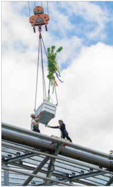
Bokrétaünnepség az Alba Arénában: elérte legmagasabb pontját a csarnok épülete
